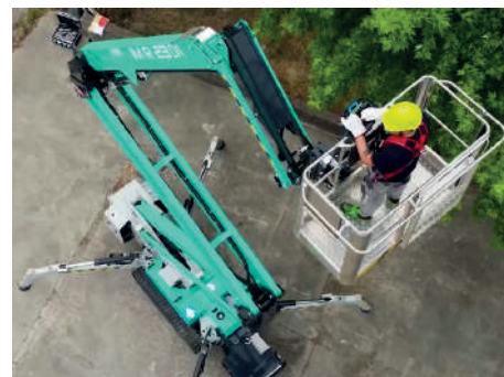
Flèche hydraulique active et rotation du panier à \pm 62^\circ : placement complet sur le chantier dans toutes les conditions.
