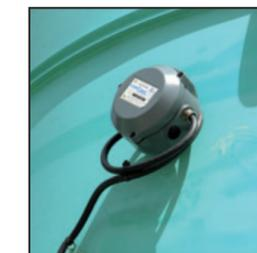
> Niveau bas du silo à ciment et indicateur de niveau
