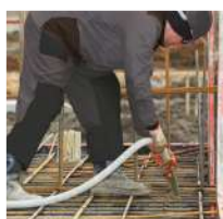
VIBRATION Convertisseurs et aiguilles vibrantes
